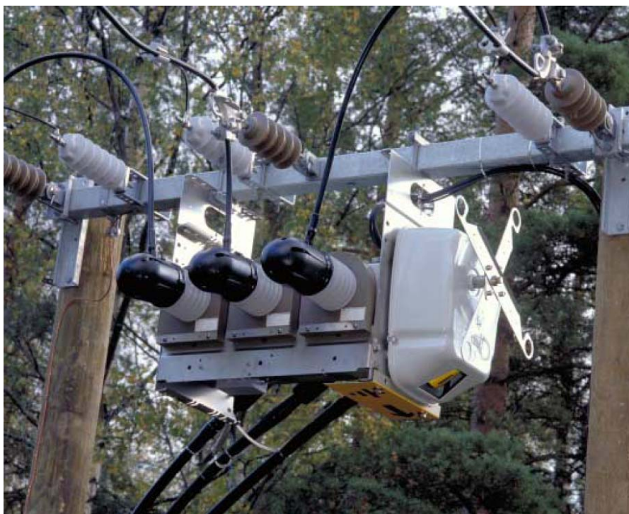
Obr. 2.6. Úsekový odpínač pre montáž na stožiar - Sectos NXB
